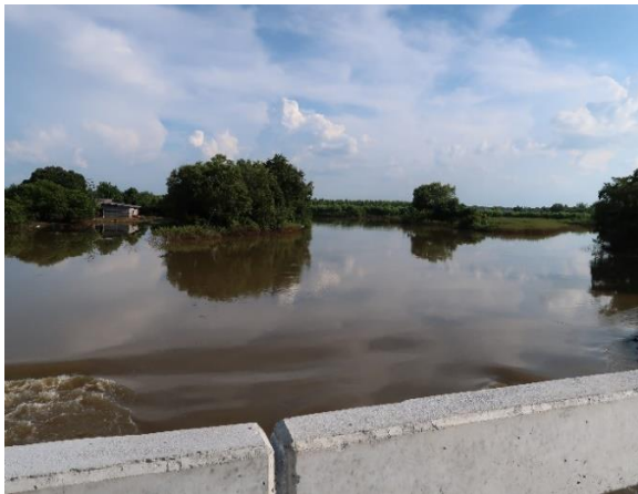
บริเวณที่จะก่อสร้างอาคารบังคับน้ำบ้านแทนพระ
